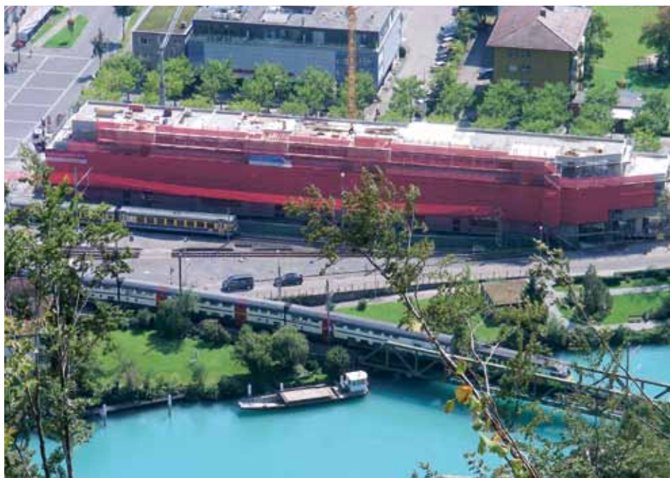
Blick von oben auf den Neubau. Links entsteht die Raiffeisenbank Jungfrau, rechts die Jugendherberge Interlaken.
